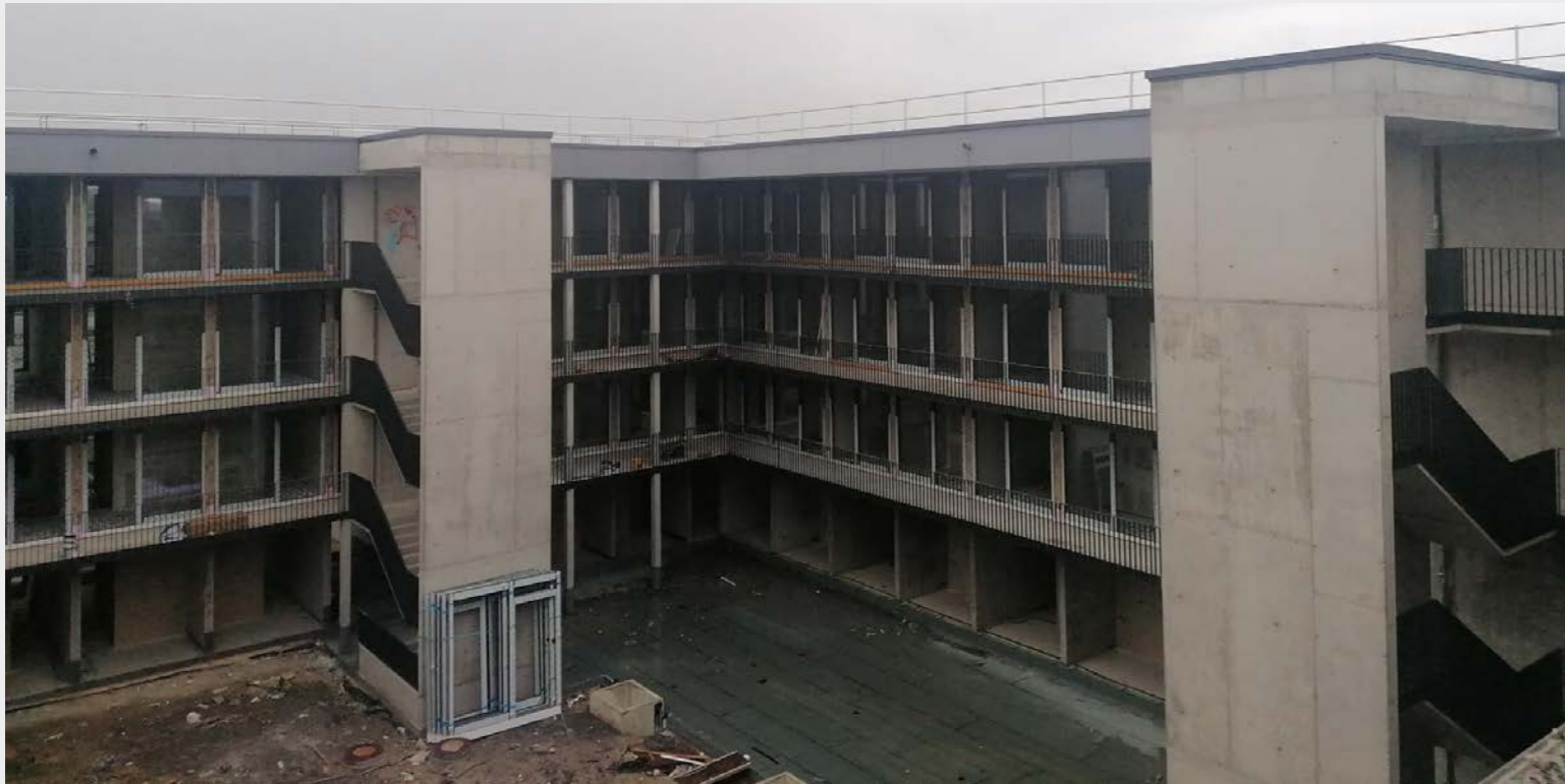
Neubau Klara Oppenheimer Weg, Hofansicht
