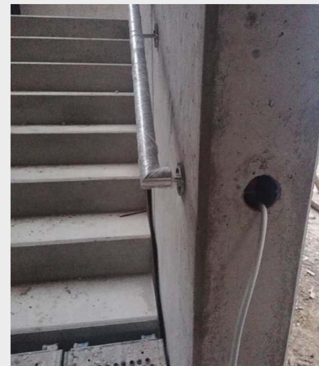
Neubau Klara Oppenheimer Weg, Detail Treppen
